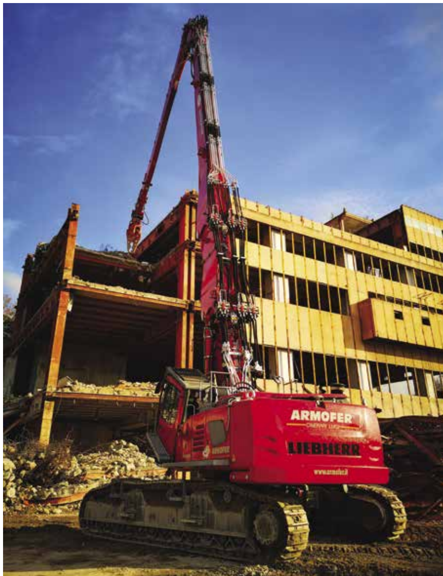
◀ L'ESCAVATORE LIEBHERR 960 RAGGIUNGE I 35 M AL PERNO, CON LA POTENZA NECESSARIA PER DEMOLIRE E MOVIMENTARE LE PUTRELLE DI DIMENSIONI MAGGIORI
