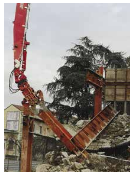
◀ L'ESCAVATORE LIEBHERR 960 RAGGIUNGE I 35 M AL PERNO, CON LA POTENZA NECESSARIA PER DEMOLIRE E MOVIMENTARE LE PUTRELLE DI DIMENSIONI MAGGIORI
