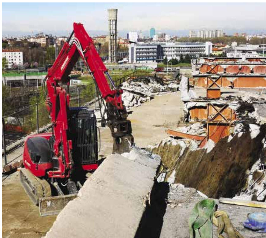
➤ L'ESCAVATORE CINGOLATO KUBOTA DA 80 Q DURANTE LA FASE DI DEMOLIZIONE IN COPERTURA DELL'EDIFICIO
