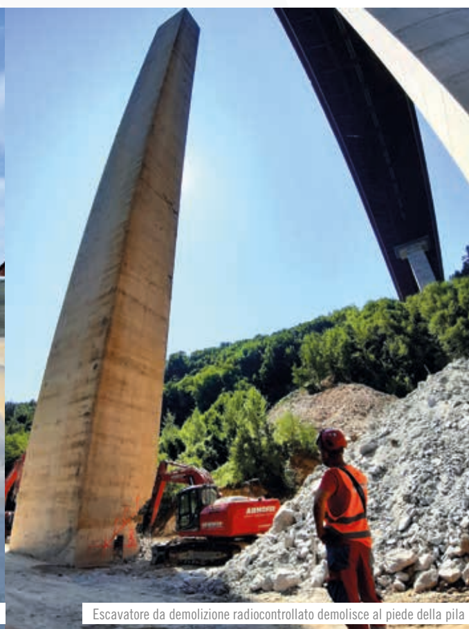
Robot da demolizione in sommità della pila, a 80 m di altezza
