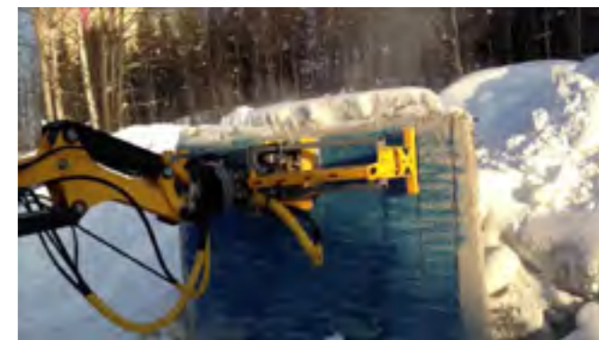
Scarificatrice planare per amianto in campo prove
