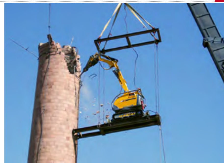
Demolizione di una ciminiera: il Brokk lavora come una centralina idraulica sospeso alla gru di cantiere con un sistema di slitte per ancorarsi al manufatto
