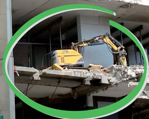
IL Brokk 160 al lavoro
