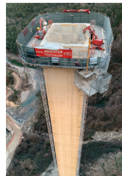
Sicurezza prima di tutto. Demolizione con robot radiocomandati sulle pile più alte di un viadotto autostradale.
