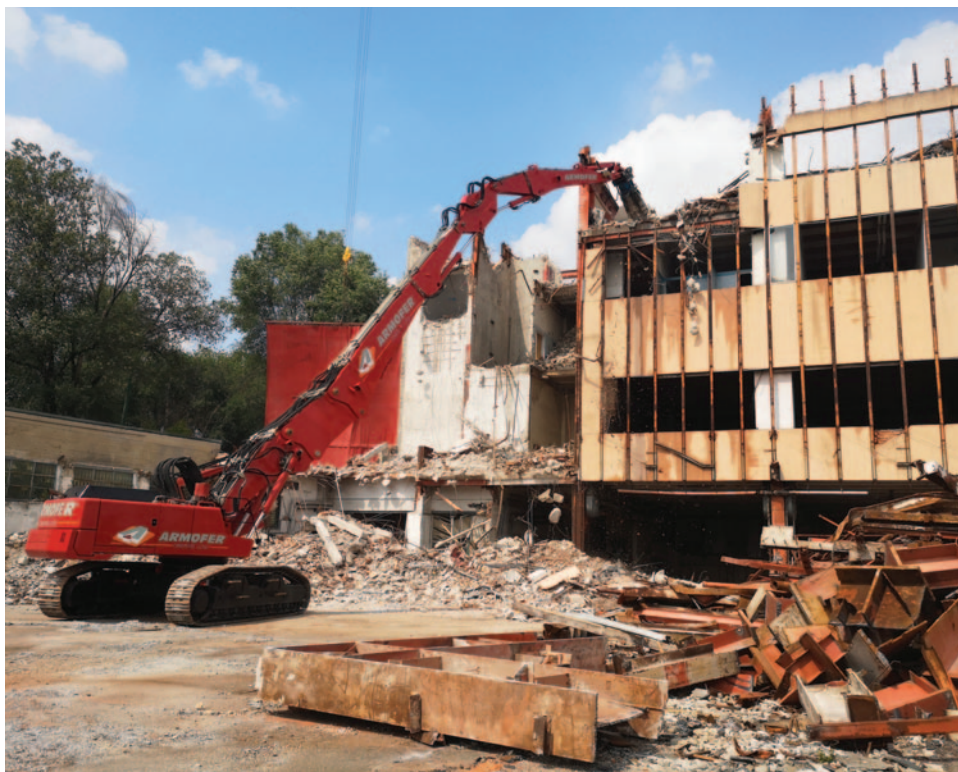
Abbatere rumore, polvere e vibrazioni, non solo l'edificio. Demolizione palazzo in c.a. in centro città
