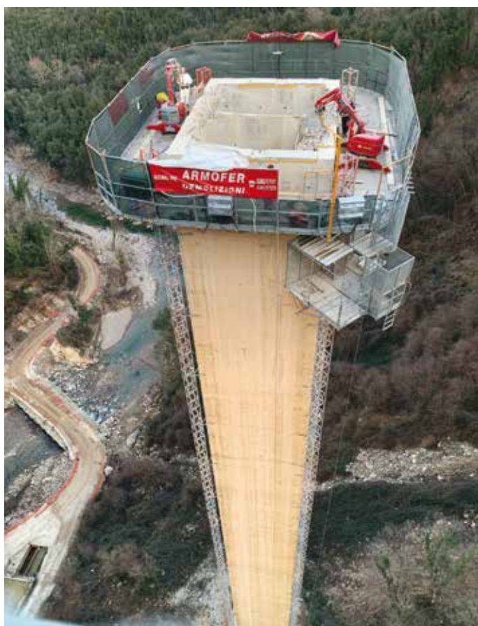
1. La demolizione della pila dalla sommità, a 80 m
