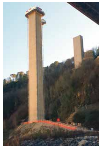
2. Il cantiere di demolizione allestito in sommità della pila
