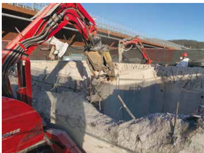
4A e 4B. Due Brokk con pinza per calcestruzzo e un martello affrontano la demolizione
