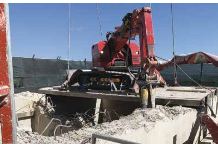
7. Il Brokk 400 demolisce a sbalzo sul vuoto: la piattaforma è appoggiata alle pareti della pila
