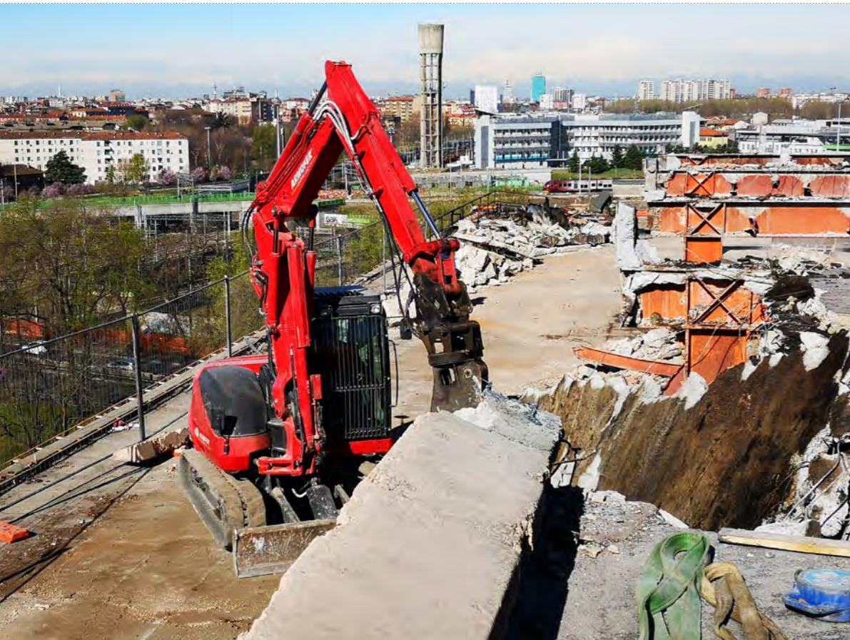
► Escavatore cingolato da 80 q demolisce l'edificio in copertura
