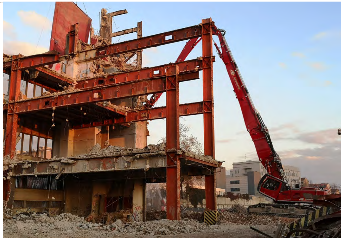
► Il telo rosso in PVC, sospeso alla gru, limita la proiezione di polvere e macerie. Escavatore Liebherr 960
