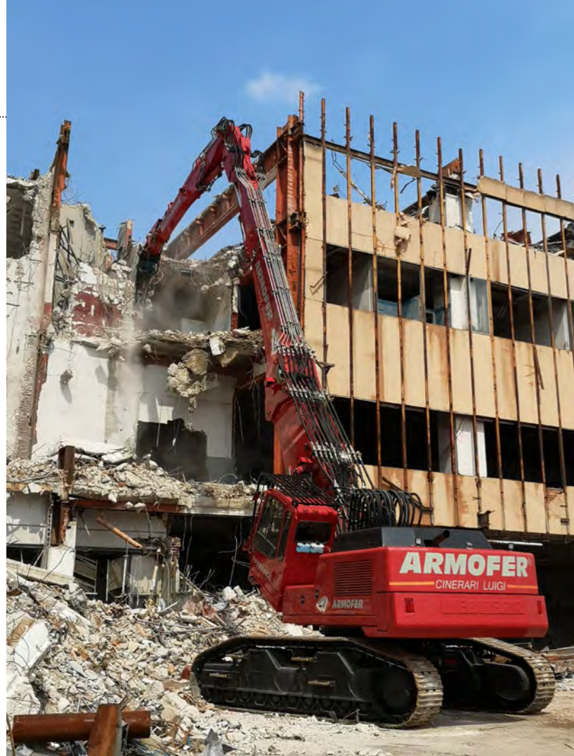
► Escavatore cingolato Liebherr 954. Demolizione top down di una porzione dell'edificio
