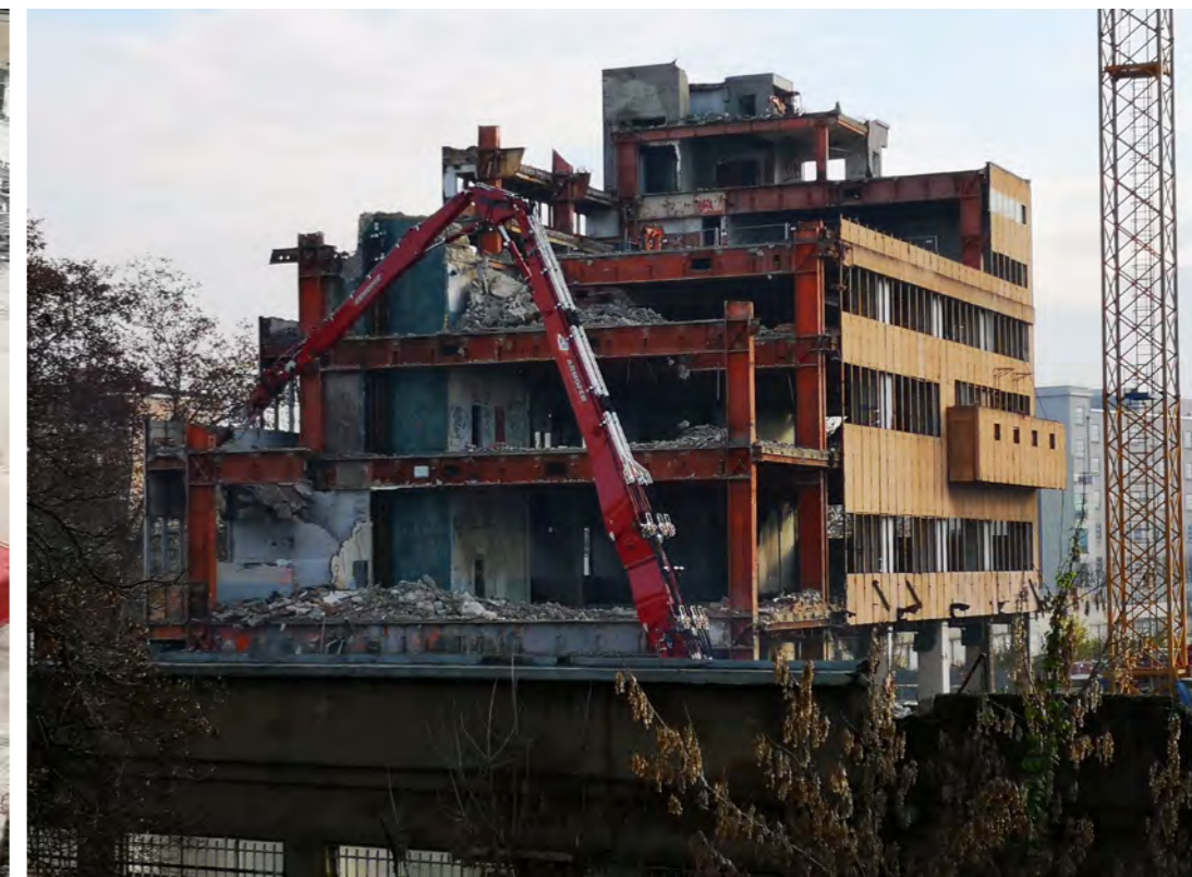
► Una fase della demolizione top down da terra con il braccio UHD vista dal vicino cavalcavia
