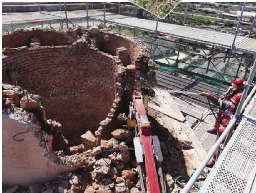
> IL CANTIERE ARMOFER PRESSO ITALCEMENTI, A ISOLA DELLE FEMMINE (PA)
