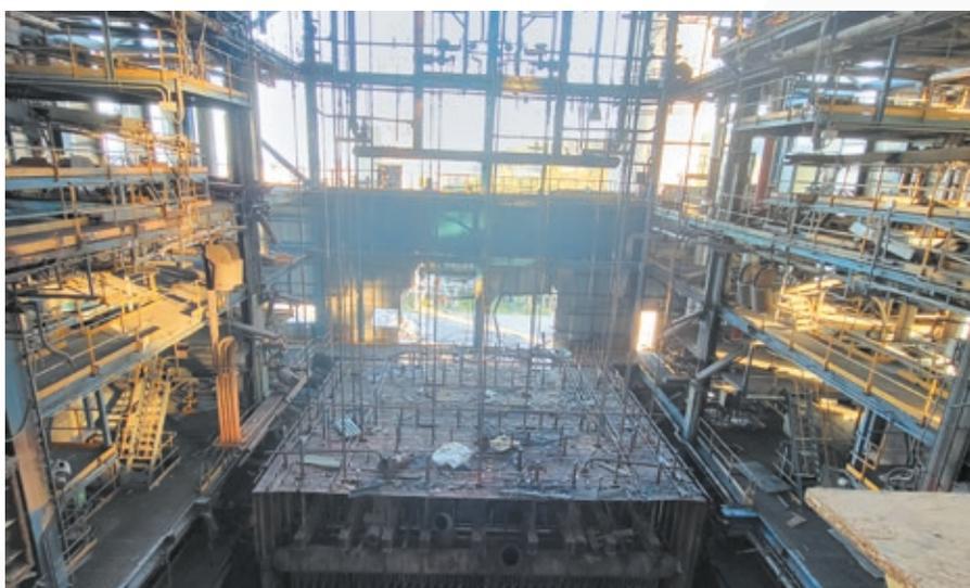
ton, per ragioni di sicurezza è stato suddiviso in due blocchi, grazie alla configurazione dell'oggetto costituito da una camera di combustione vera e propria e dall'economizzatore, "facilmente" separabili l'uno dall'altro con opportuni sezionamenti di servizio.
