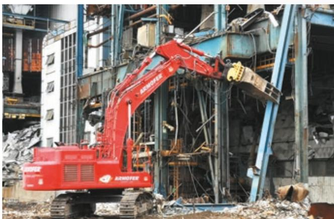
schema statico delle strutture, secondo le esigenze degli ingegneri che prima dell'intervento studiano lo schema statico del manufatto e predispongono le modalità di presa in carico e gestione operativa dell'impianto.
